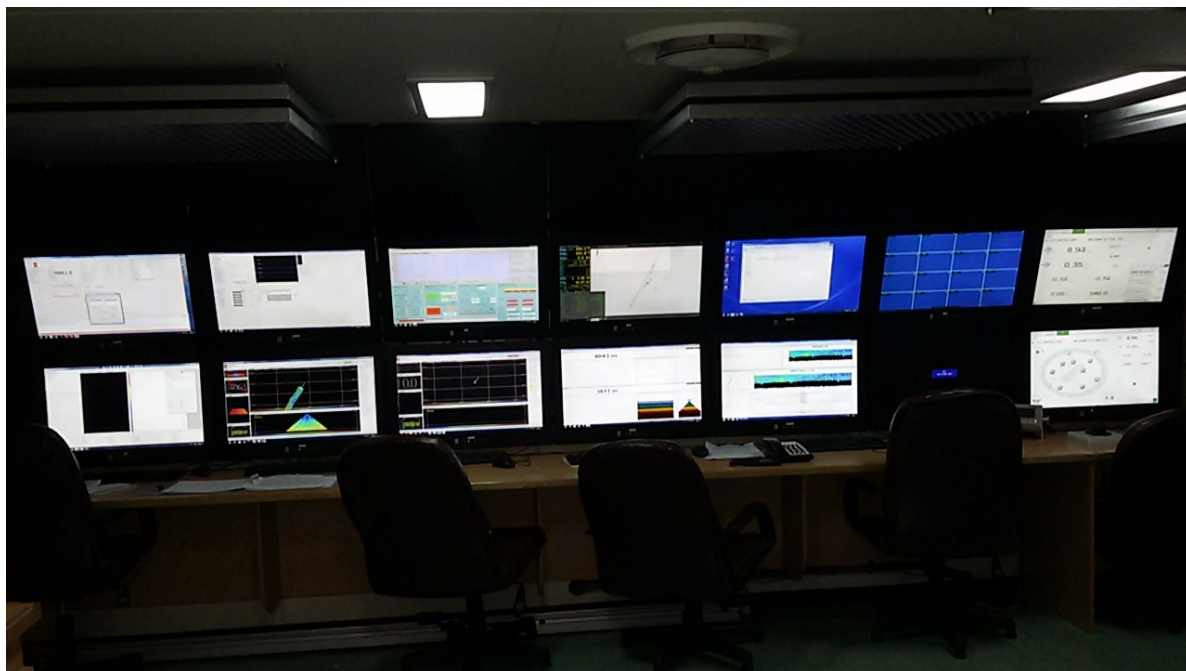
Figura 4 - Laboratório Seco - Equipamentos sendo utilizados na sondagem.
