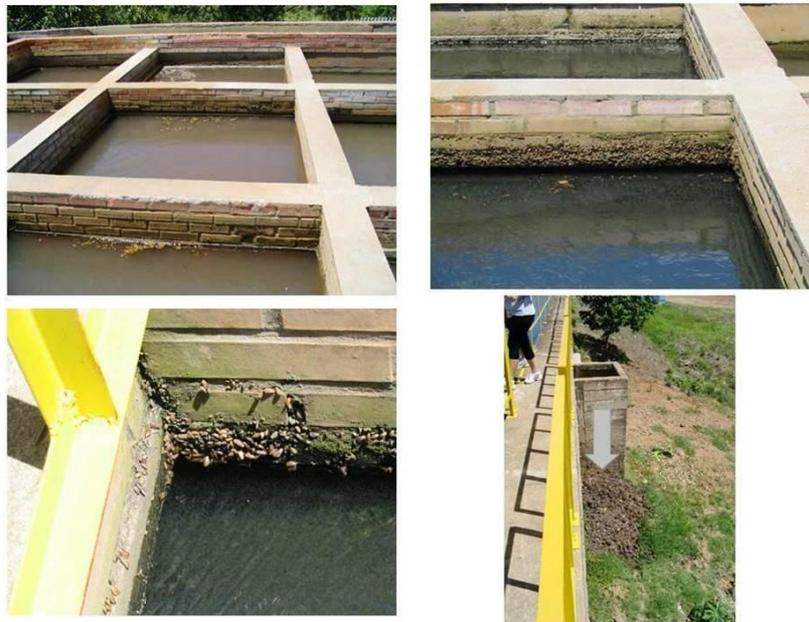
Figura 16. Estação da Corsan no Rio Grande do Sul mostrando a colonização de tanques pelo mexilhão-dourado e o resíduo removido. Foto: M.C.D.Mansur
